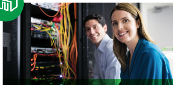
SERVIDORES DE ENTRADA E PEQUENOS DATA CENTERS
